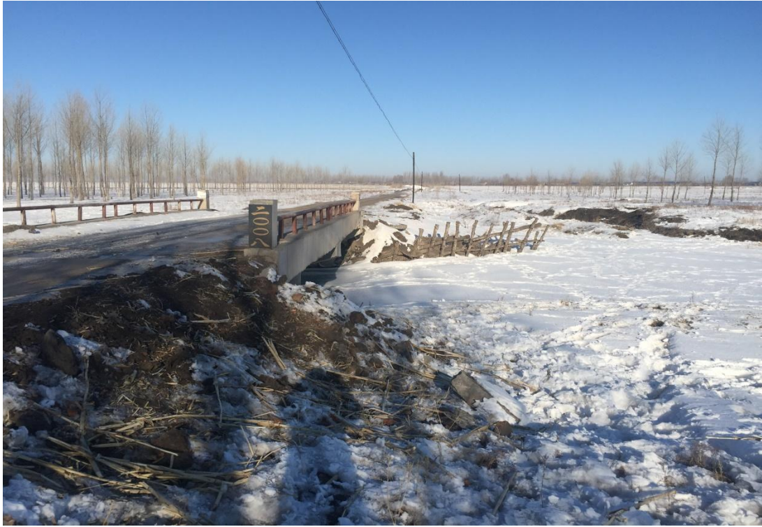
图 1.4-2 先锋沟农开桥现状
