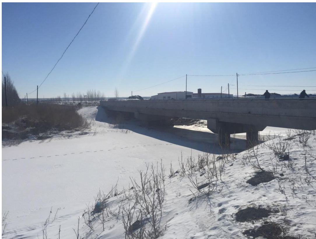
图 1.1-2 先锋沟现有桥梁
